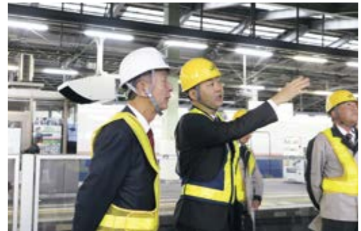
▲新潟駅周辺整備事業で新幹線と在来線が同一ホームになる工事現場を視察する篠田昭市長（左）
